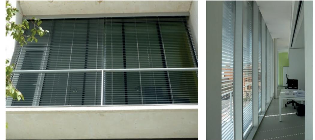
Después de la instalación de la fachada dinámica se registran 6 °C menos de temperatura en el interior del edificio mejorando el confort del usuario y el ahorro energético en climatización.
