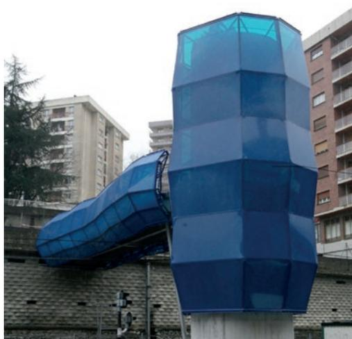
Figura 33. Acabado del ETFE en lámina de color
